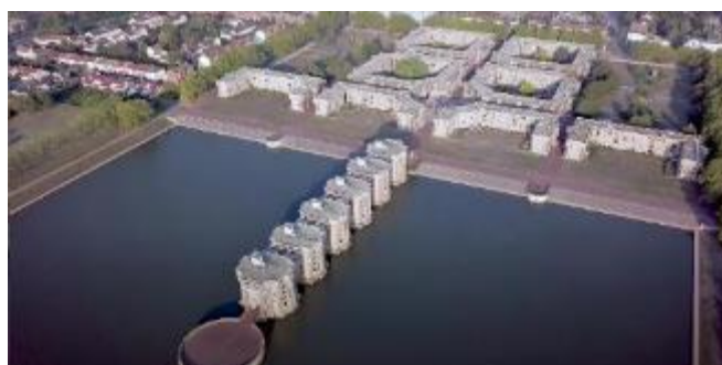
17 Vue aérienne des Arcades du Lac. (Photo source Musée de la Ville de Saint-Quentin-en-Yvelines, Patrimoine et territoire. )
